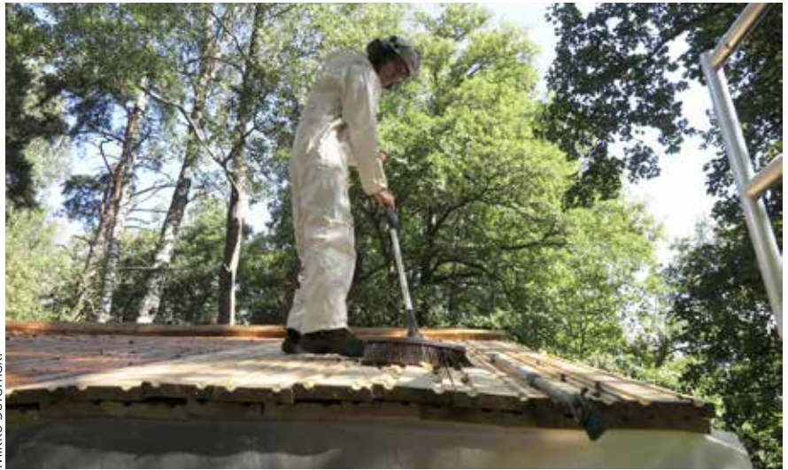
Ennen tervauksia katto puhdistettiin huolellisesti harjaamalla.
