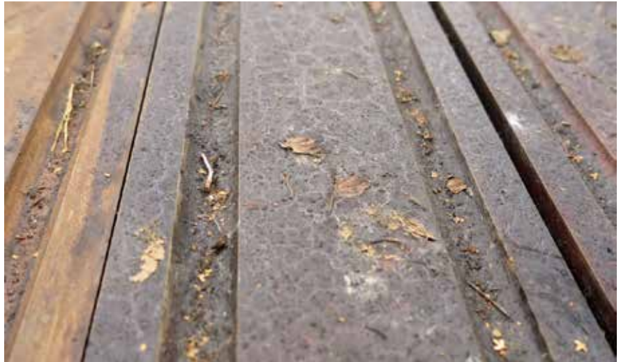
Retorttitervan pinta 3. kerroksen jälkeen.
